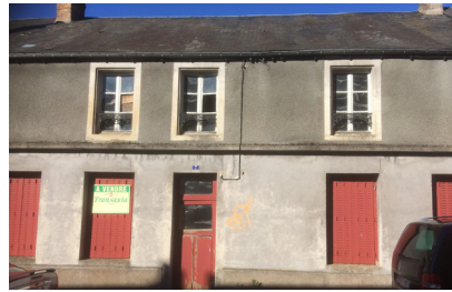
habitat dégradé : îlot 7 rue St-Christophe
