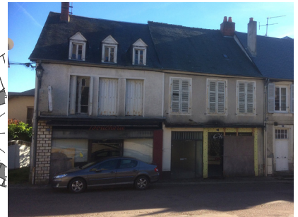
habitat dégradé : îlot 8 rue du marché
