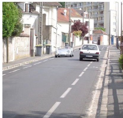
Chaucidou à Avon (6m de chaussée au total avec bandes et double sens)
