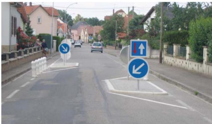
Ecluse et «by-pass»
